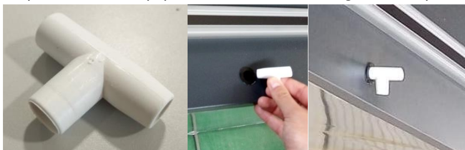
Fig. 9 - Ilustração de colocação do racor
