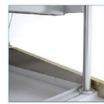
Détail colonne intérieur
