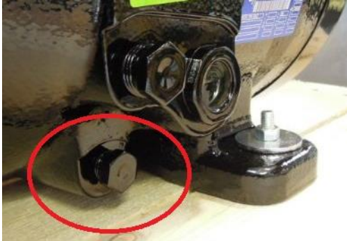
Figure 40 : Position du bouchon de vidange d'huile
